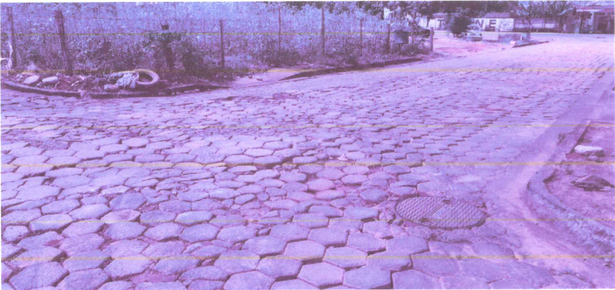
Foto 03: Trecho da Rua Santa Terezinha, para execução do calçamento do pavimento intertravado sextavado.
