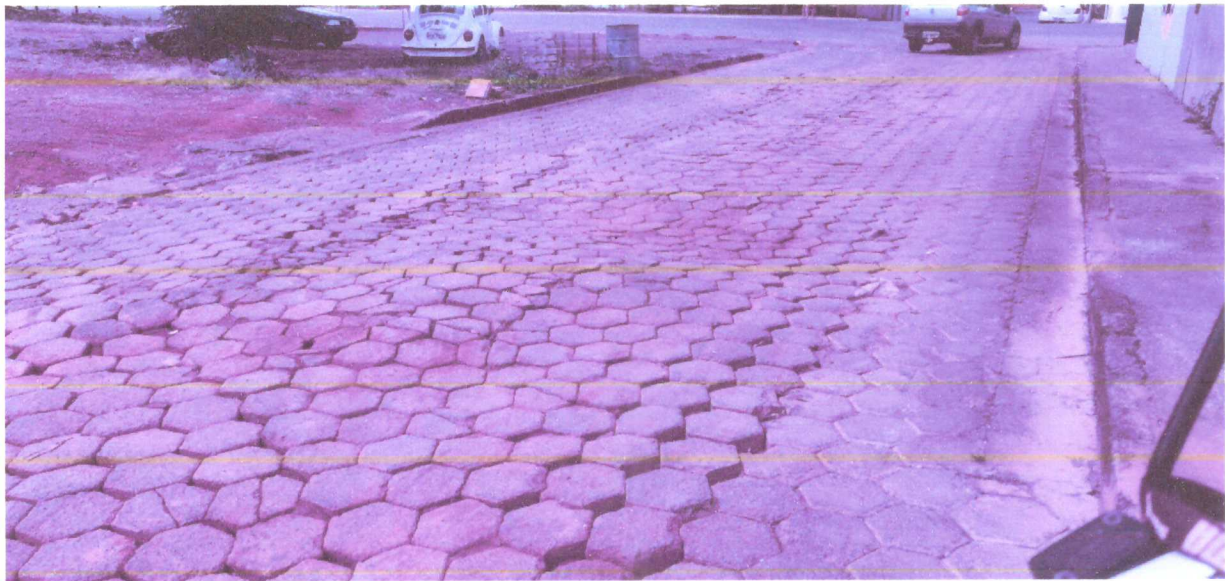
Foto 04: Trecho da Rua Santa Terezinha, para execução do calçamento do pavimento intertravado sextavado.
