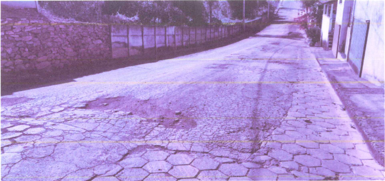
Foto 06: Trecho da Rua Manoel Adolfo, para execução do calçamento do pavimento intertravado sextavado.
