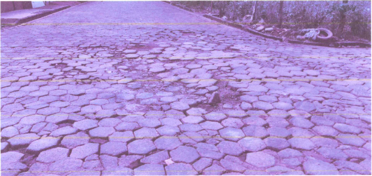
Foto 02: Trecho da Rua Santa Terezinha, para execução do calçamento do pavimento intertravado sextavado.
