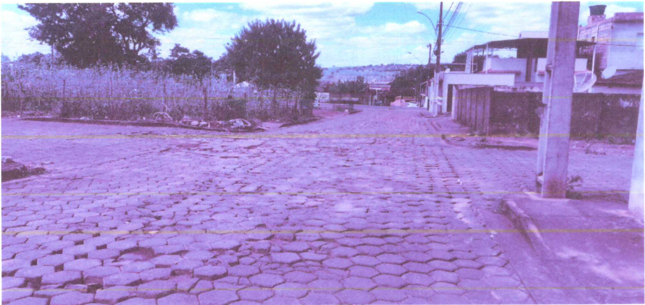
Foto 01: Trecho da Rua Santa Terezinha, para execução do calçamento do pavimento intertravado sextavado.
