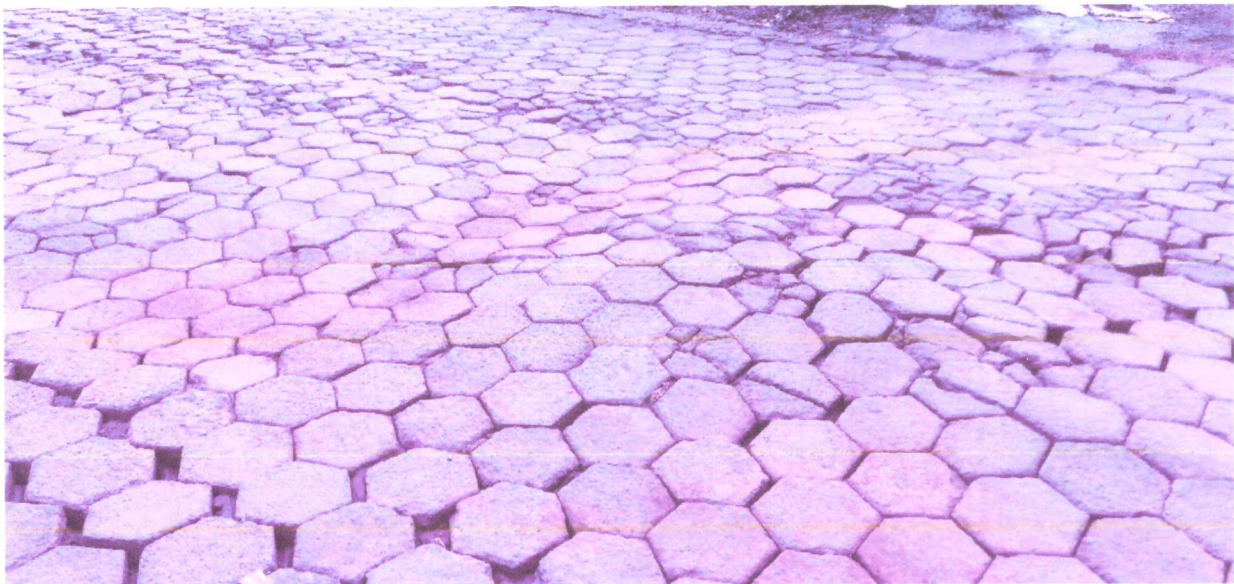
Foto 05: Trecho da Rua Santa Terezinha, para execução do calçamento do pavimento intertravado sextavado.
